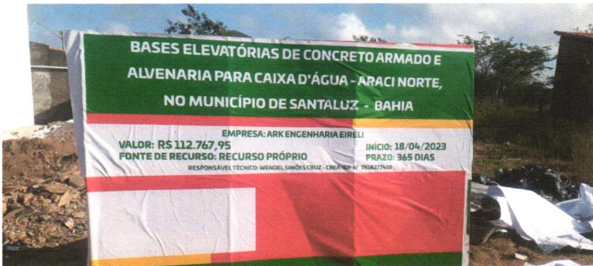
FOTO 01 – Placa de obra em chapa aço galvanizado, instalada - Rev 02_01/2022
