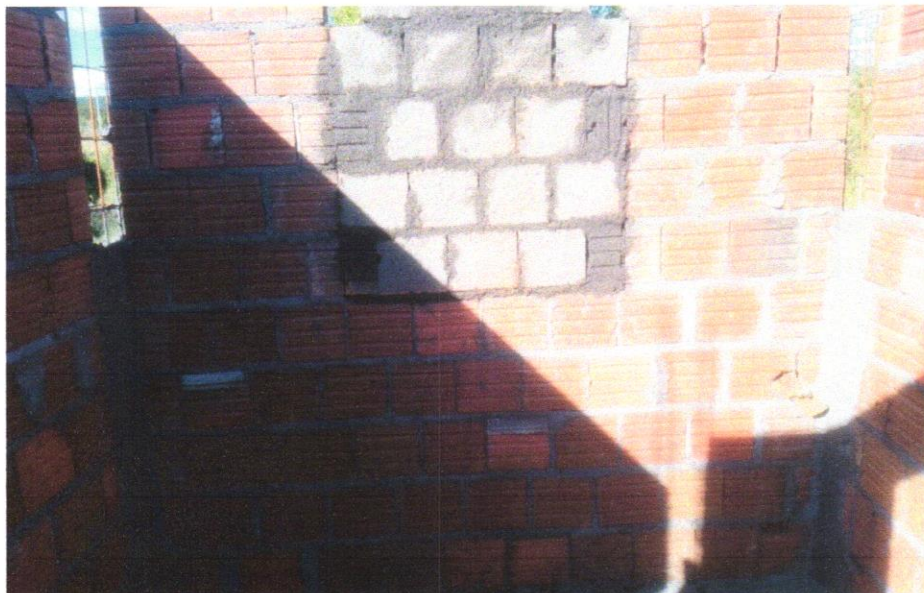
FOTO 17 –ALVENARIA DE VEDAÇÃO DE BLOCOS CERÂMICOS FURADOS NA HORIZONTAL DE 9X19X19CM (ESPESSURA 9CM) DE PAREDES COM ÁREA LÍQUIDA MENOR QUE 6M² SEM VÃOS E ARGAMASSA DE ASSENTAMENTO COM PREPARO EM BETONEIRA. AF_06/201
