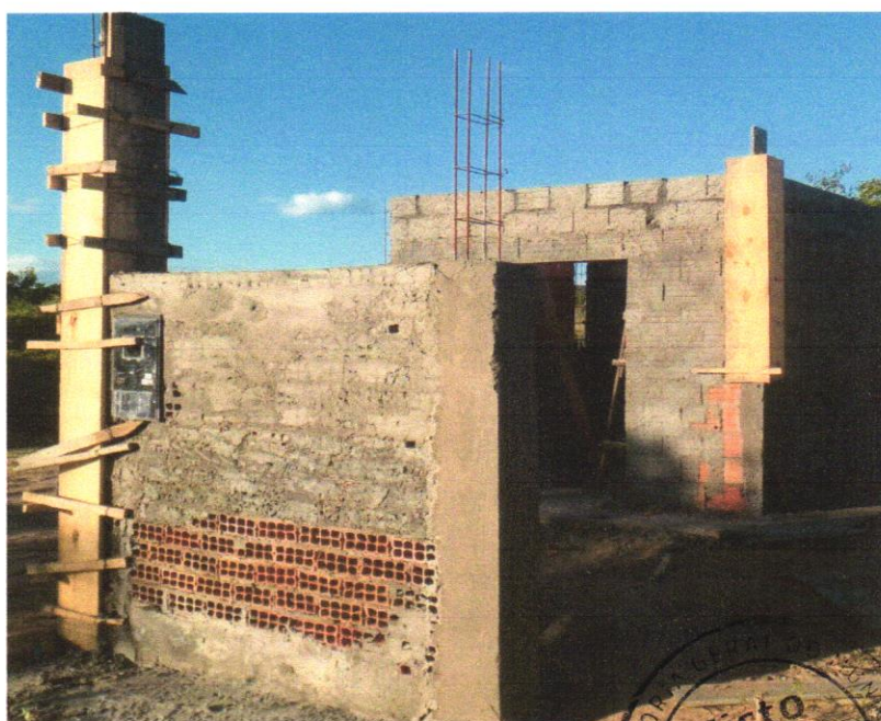
FOTO 08 – ARMAÇÃO DE PILAR OU VIGA DE UMA ESTRUTURA CONVENCIONAL DE CONCRETO ARMADO EM UM EDIFÍCIO DE MÚLTIPLOS PAVIMENTOS UTILIZANDO AÇO CA-50 DE 8,0 MM -MONTAGEM. AF_12/2015
