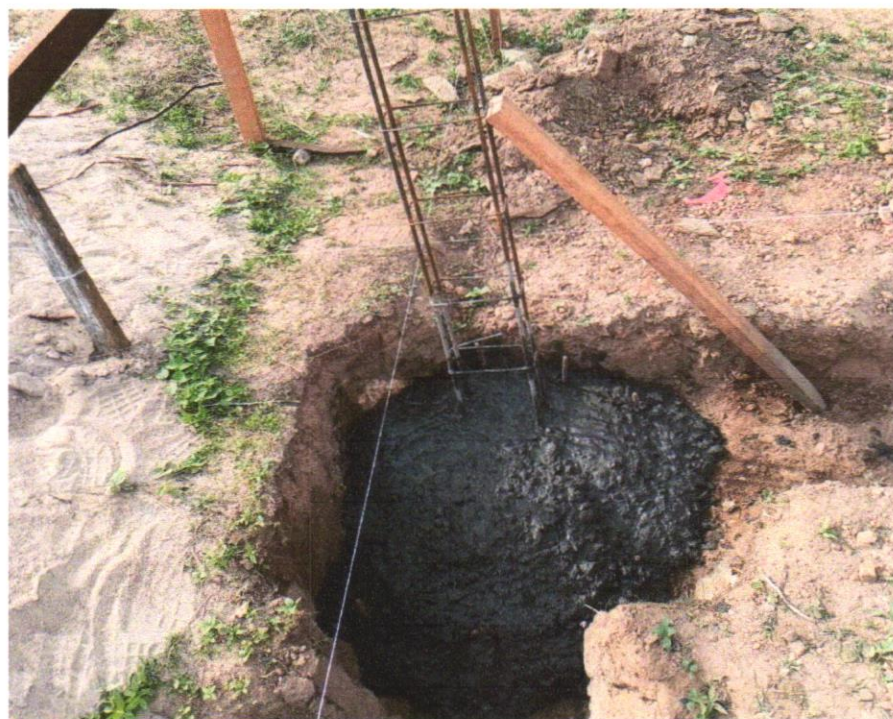
FOTO 05 – CONCRETO FCK = 20MPA, TRAÇO 1:2,7:3 (EM MASSASECA DE CIMENTO/ AREIA MÉDIA/ BRITA 1)- PREPARO MECÂNICO COM BETONEIRA 400 L. AF_05/202
