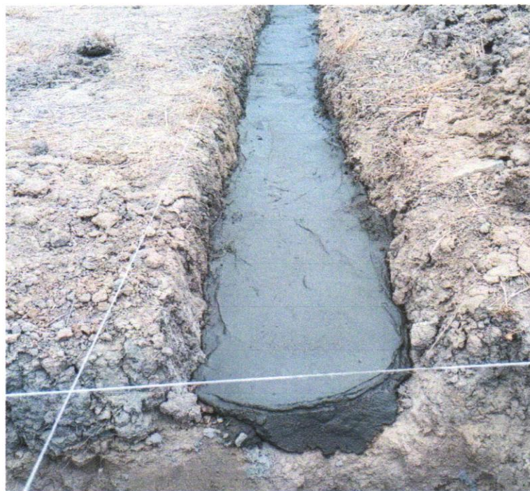
FOTO 07 – LASTRO DE CONCRETO MAGRO, APLICADO EM BLOCOS DE COROAMENTO OUSAPATAS, ESPESURA DE 3 CM. AF_08/2017
