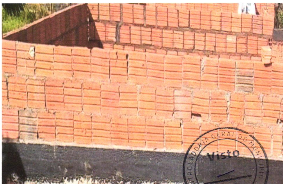
Foto 06 – IMPERMEABILIZAÇÃO DE SUPERFÍCIE COM EMULSÃO ASFÁLTICA, 2 DEMAOSAF_06/20
