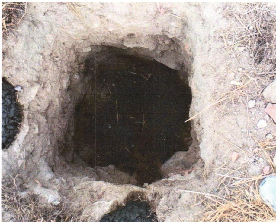
FOTO 03 -ESCAVAÇÃO MANUAL PARA BLOCO DE COROAMENTO OU SAPATA (INCLUINDO ESCAVAÇÃO PARA COLOCAÇÃO DE FÔRMAS). AF_06/2017
