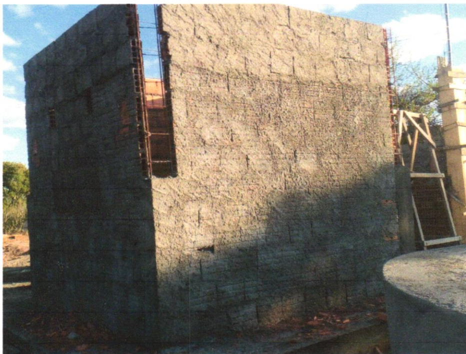
Foto 11 - CHAPISCO APLICADO EM ALVENARIAS E ESTRUTURAS DE CONCRETO INTERNAS, COM COLHER DE PEDREIRO. ARGAMASSA TRAÇO 1:3 COM PREPARO EM BETONEIRA 400L. AF_06/2014
