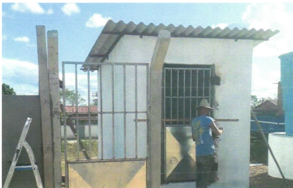
Foto 13 - TELHAMENTO COM TELHA DE FIBROCIMENTO
