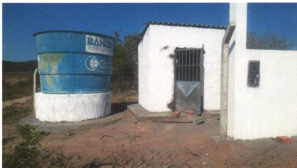
Foto 14- APLICAÇÃO MANUAL DE PINTURA COM TINTA LÁTEX ACRÍLICA EM PAREDES, DUAS DEMÃOS.
