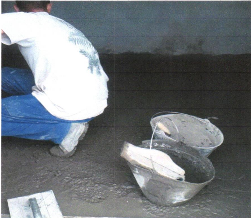
Foto 15 ARGAMASSA TRAÇO 1:3 (EM VOLUME DECIMENTO E AREIA MÉDIA ÚMIDA) PARA CONTRAPISO, PREPARO MECÂNICO COM BETONEIRA 600 L. AF_08/2019
