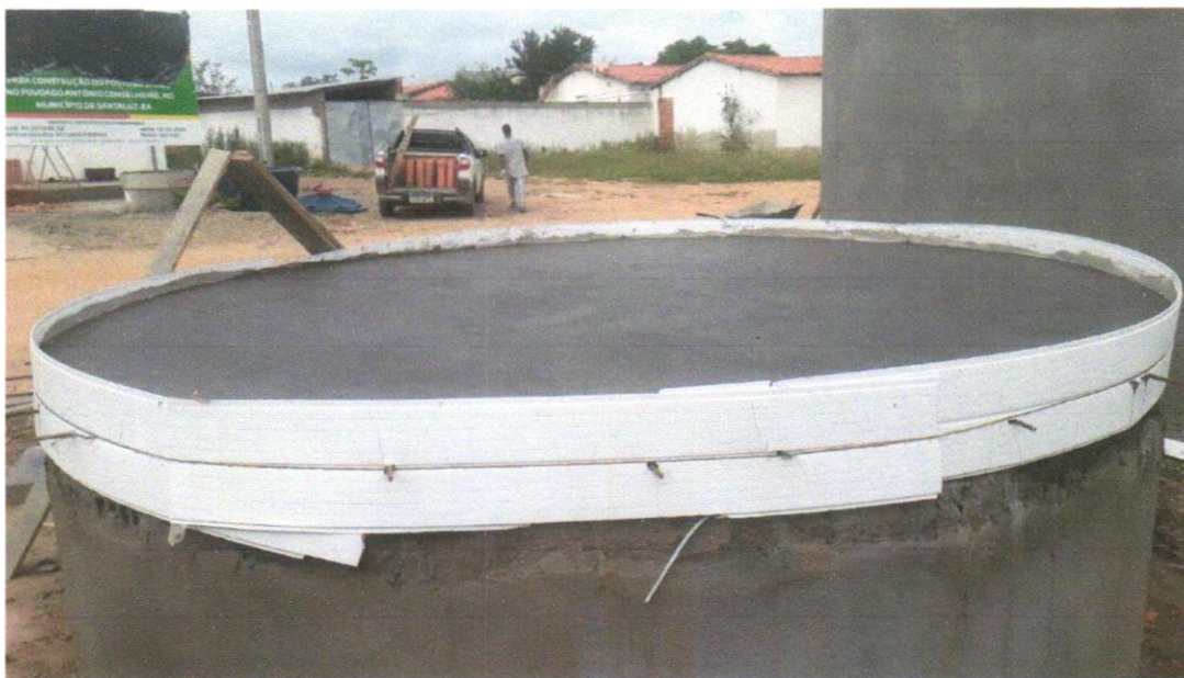
FOTO 09 – CONCRETO FCK = 20MPA, TRAÇO 1:2,7:3 (EM MASSASECA DE CIMENTO/ AREIA MÉDIA/ BRITA - PREPARO MECÂNICO COM BETONEIRA 600 L.AF_05/2021
