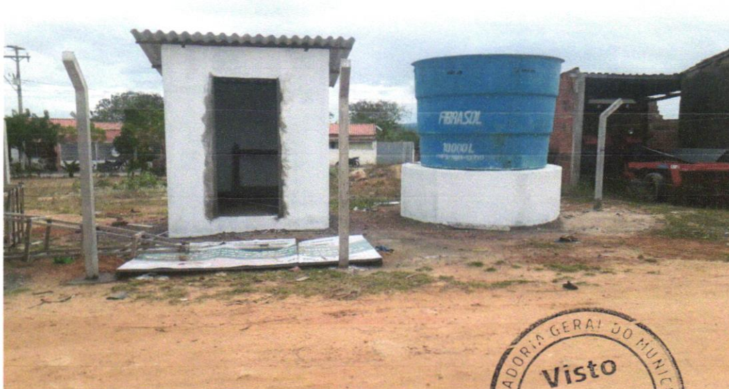
Foto 16 - APLICAÇÃO MANUAL DE PINTURA COM TINTA LÁTEX ACRÍLICA EM PAREDES, DUAS DEMÃOS. AF_06/2014 marca Araforros ou similar, instalado - Rev 06
